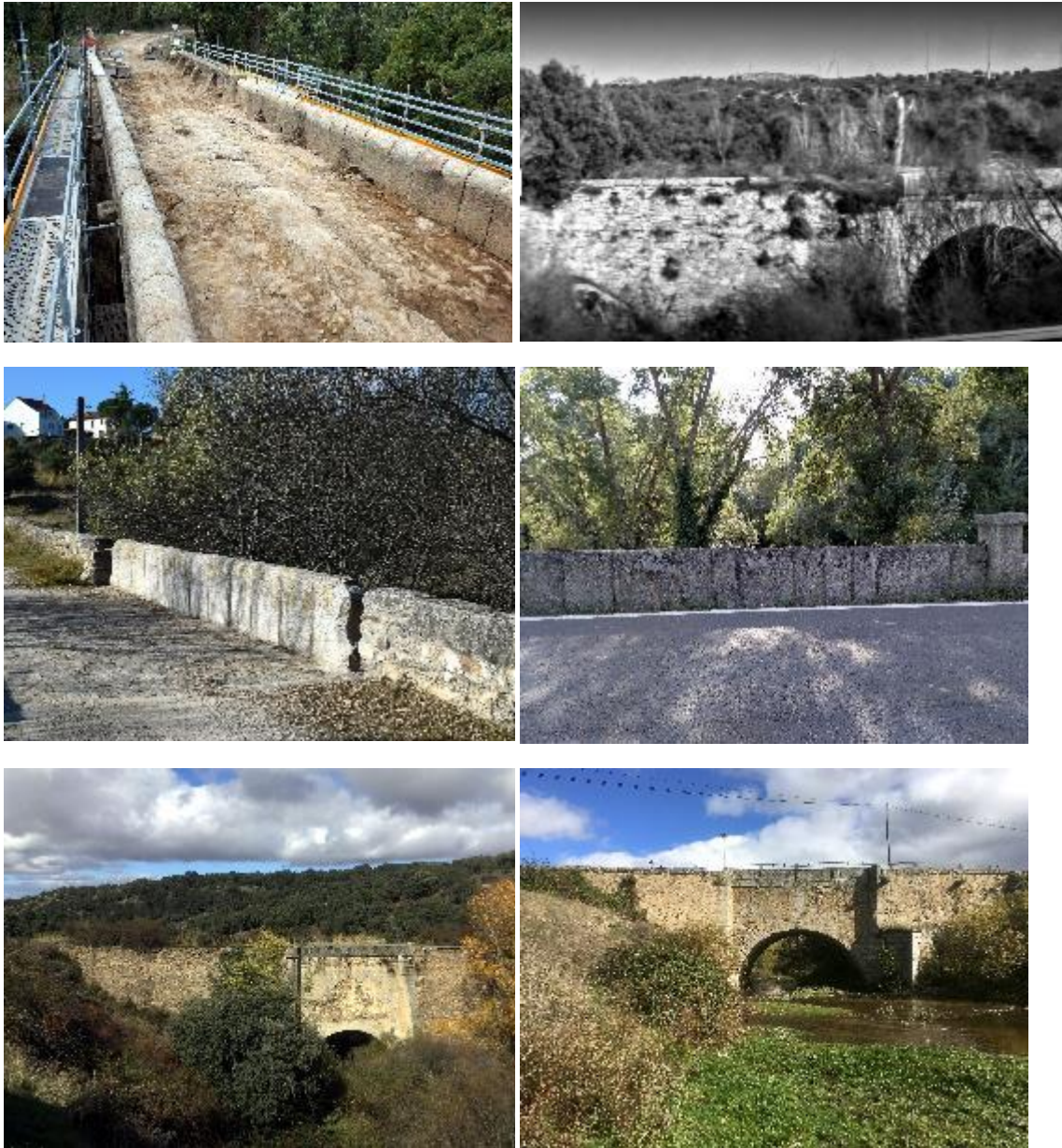
Figura 13: transición entre el pretil de los estribos y el del tablero. De arriba abajo y de izquierda a derecha, Horcajo de la Sierra, Galapagar, Cabanillas de la Sierra, Pulimento en San Ildefonso, Puente Alta de Revenga y puente sobre el Eresma en Valsain
