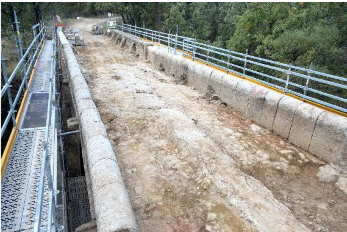
Figura 20. Alteración del pavimento original por la construcción de una canalización con cubierta de hormigón.
