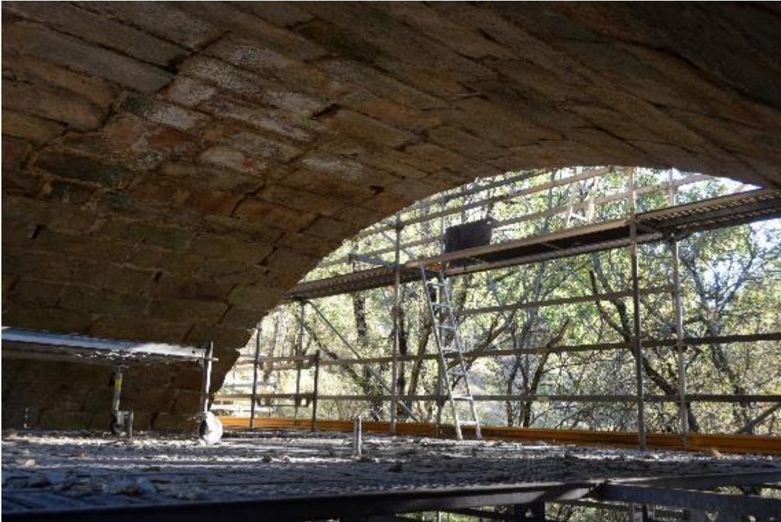
Figura 17. Bóveda de sillería durante los trabajos de restauración del puente.
