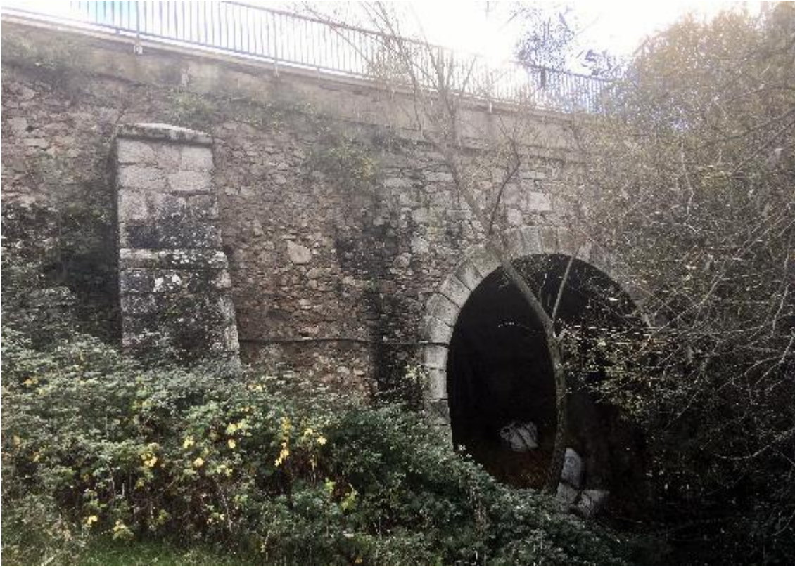
Figura 12: Puente en Valsaín sobre el arroyo de La Chorranca , actualmente al servicio de la carretera CL-601.
