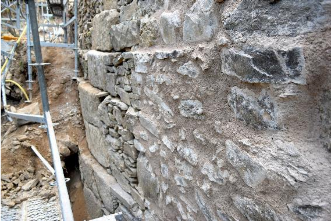
Figura 18. Zapata de sillaría, escalonada, que refuerza la fachada del puente aguas arriba en su margen izquierda.
