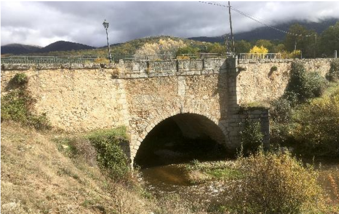
Figura 11: Valsaín, puente sobre el Eresma. Se distinguen las dos fases, la inicial, del siglo XVI, con doble rosca y tajamares hasta la altura original del tablero, y la del siglo XVIII, con el pretil, de sillería, diferenciado de los estribos, de mampostería.
