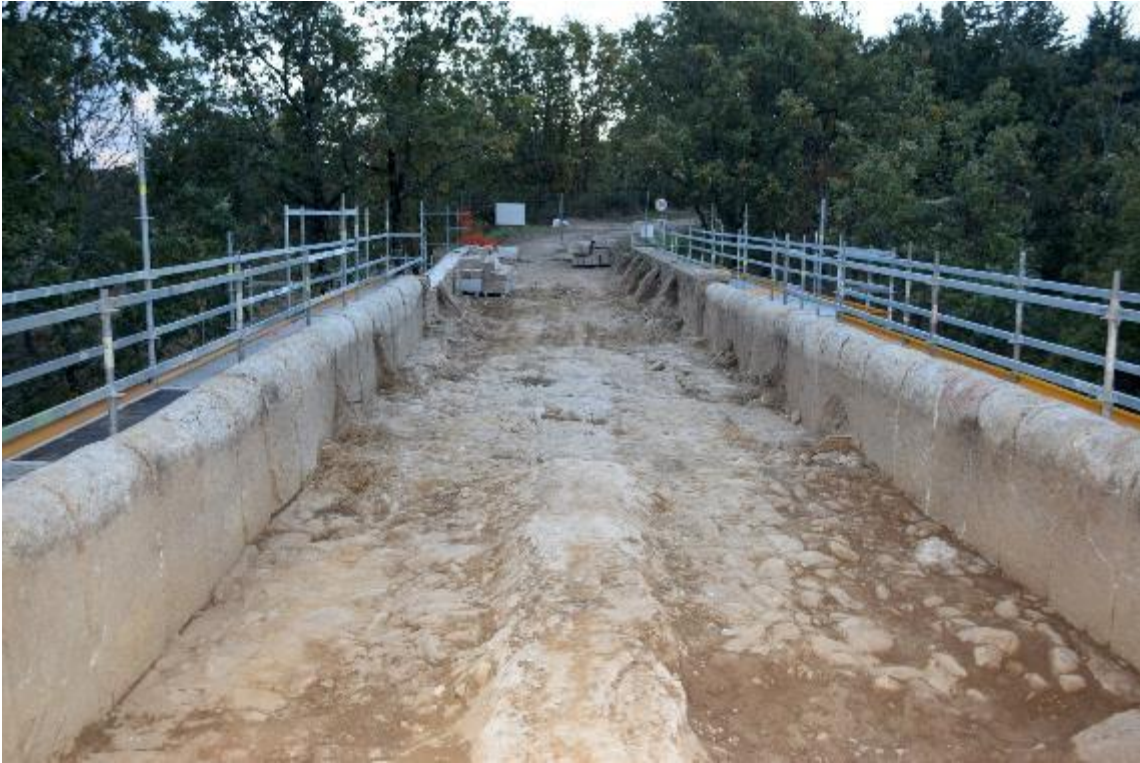
Figura 19. Pavimento de guijarros del puente, que se pierde en el último tramo del tablero.
